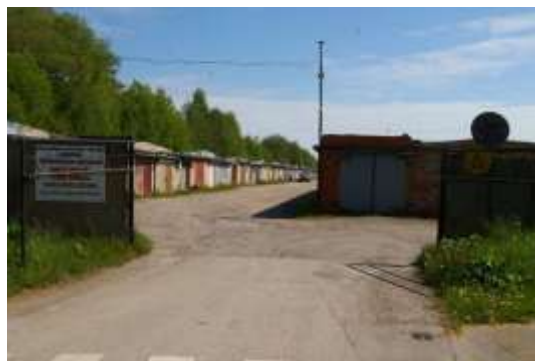
Piekļuve pie vērtējamā Objekta no Meldru ielas puses
